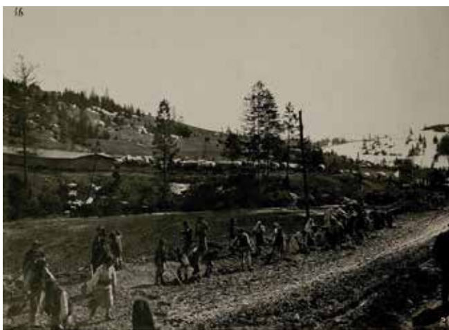
Ремонт дороги в с. Опорець
